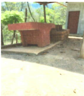
LOSA DE PATIO, REPARACION LOSA DE PATIO EN GALERA SUSTITUCION DE PILA DE CONCRETO EN MAL ESTADO, TAPADA Y RAJADA
