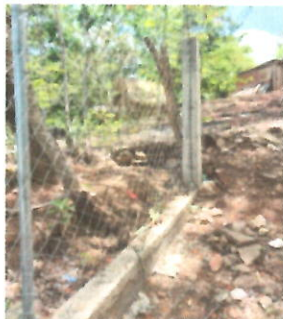
CERCO O MURO PERIMETRAL. SUSTITUCIÓN DE CERCO O MURO PERIMETRAL
