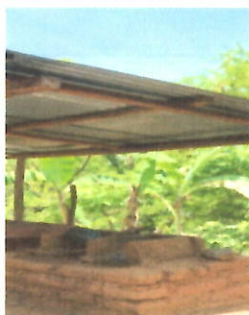
REPARACION ESTUFA RURAL CON PLANCHAS Y CHIMENEA
